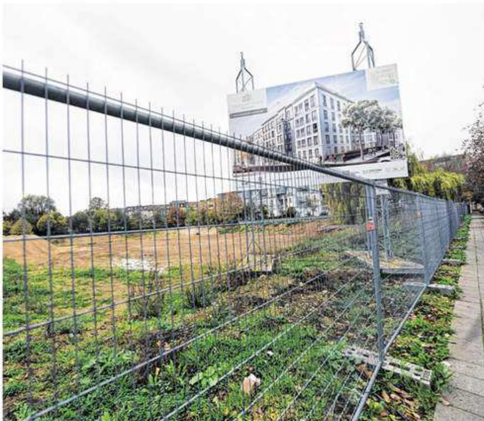
Während auf der Baustelle des geplanten Kronprinzenquartiers noch Ruhe herrscht, gibt es einigermaßen lautstarken Streit über die Lage der Sozialwohnungen. Die von der Ratsmehrheit beschlossene Konzentration im Nordriegel stößt auf massive Kritik der Opposition. Foto: Harald Krömer
