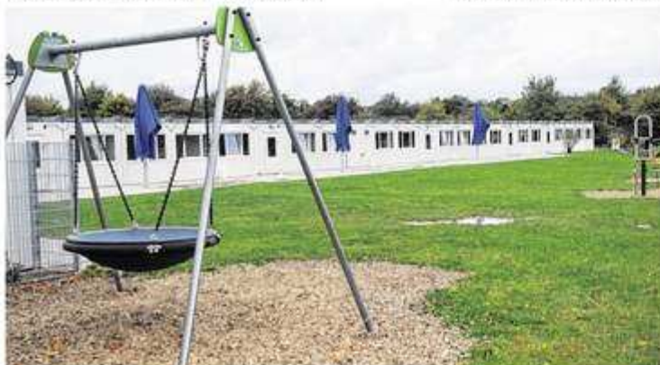
Auch das Außenspielgelände ist ganz neu angelegt worden: Die Pavillonmodule an der Schagenstraße in Brand sind das Zuhause auf Zeit für die Kita Franz-Wallraff-Straße.
