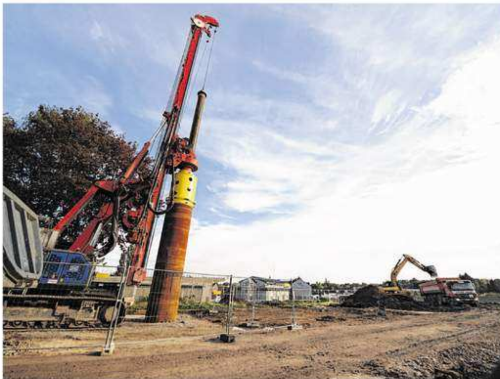
Wurde per Sondertransport am Donnerstag in Einzelteilen angeliefert: Die riesige Drehbohranlage RH 34, die in zwölf Monaten 550 bis zu 13 Meter tiefe Löcher in den Boden treibt. Fotos (4): Harald Krömer
