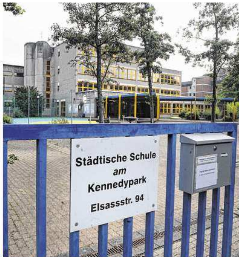
Steht seit Sommer 2013 leer: jetzt soll die Schule am Kennedypark für die Bedürfnisse der Förderschule Walheim hergerichtet werden, damit diese näher ins Zentrum der Stadt rücken kann. Foto: Harald Krömer
