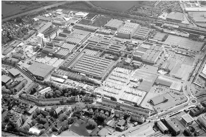
Teile des Bodens und das Grundwasser unter dem Industriepark Rothe Erde sind vergiftet. Philips arbeitet an einer aufwendigen und teuren Sanierung. Foto: Manfred Kistermann
