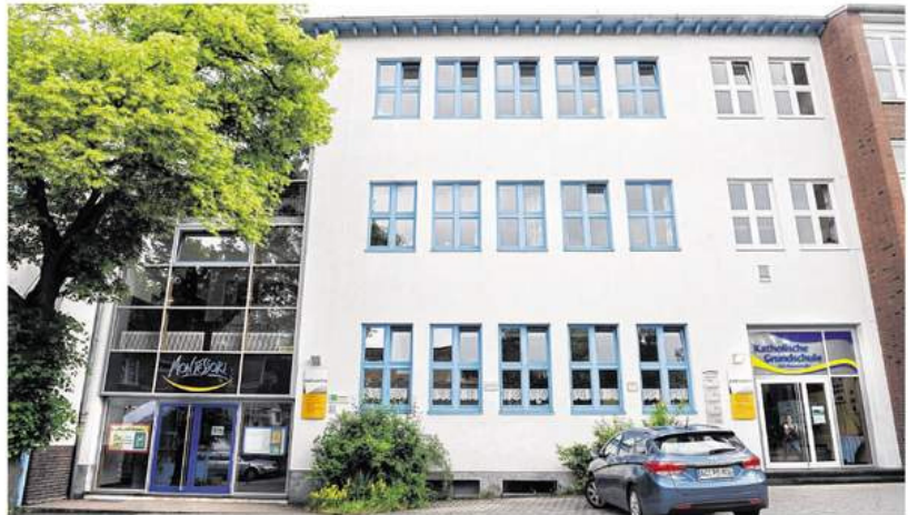
Ein Gebäude, zwei Eingänge und – noch – zwei Schulen: In der Mataréstraße wachsen die beiden Grundschulen zu einer Montessori-Schule zusammen. Foto: Harald Krömer
